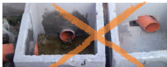
Esempio di connessione (metodo tradizionale)
