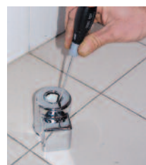
4 - adattamento della rosetta cromata (d. 1"1/4 e 1"1/2 presfondato)
