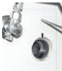
1- smontaggio del sifone esistente
