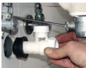
2- inserimento del corpo valvola con guarnizione tecnica montata
