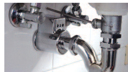
6- montaggio del sifone e armonia estetica finale
